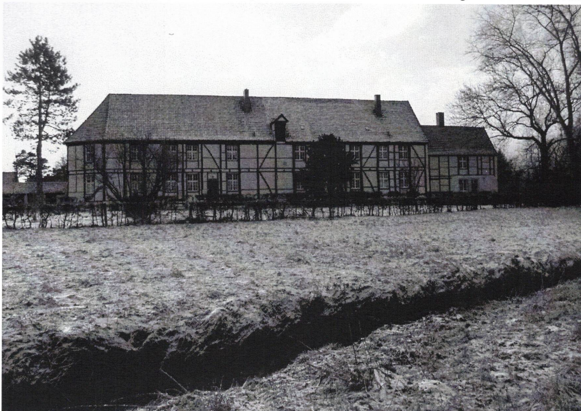
Abb. 3: Das ehemalige Pfründnerhaus Kinderhaus von Norden: Großes Fachwerkhaus von 1662–1671, Provisorenhaus von 1584 und „lutke steynen hueß“ von 1405. Foto: Katrin Jünemann, 2005.
