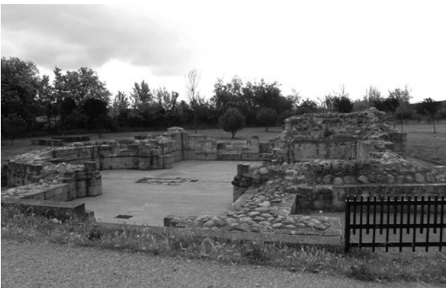
Navarrete, Grundmauern der Hospitalkirche
