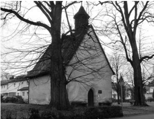
2003, noch standen zwei Linden vor dem Siechenkirchle, Foto: Karl-Otto Müller, Zollernalbkurier, 2003.
