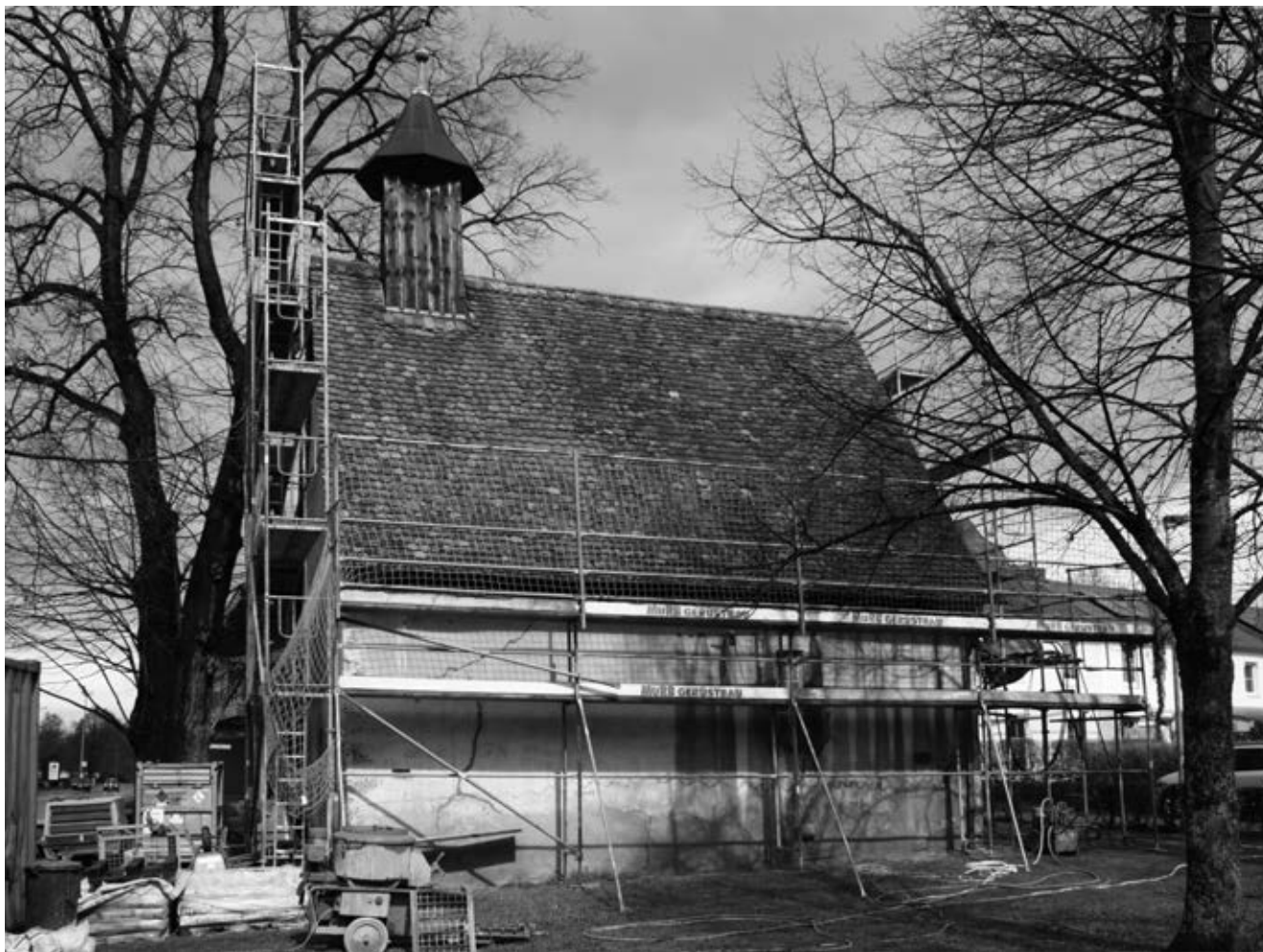
2015, die Sanierung ist im Gange, Foto: Klaus Irion, Zollernalbkurier, 31.3.2015.
